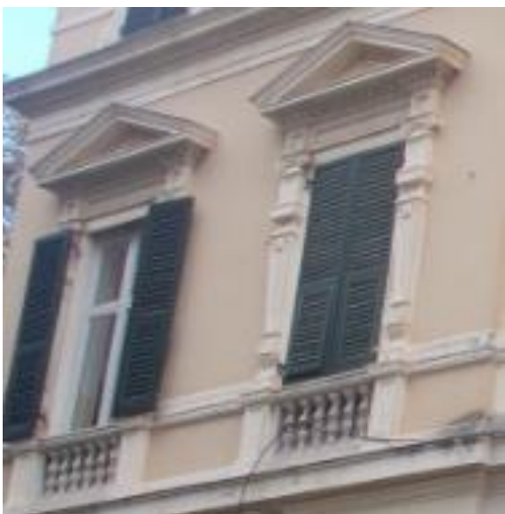
Figura 4.5 – Rilievo termografico dei serramenti
