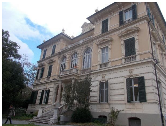
Figura 1.1 - Vista della facciata
