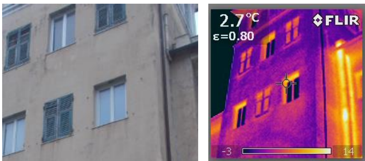
Figura 4.3 – Rilievo termografico della parete
