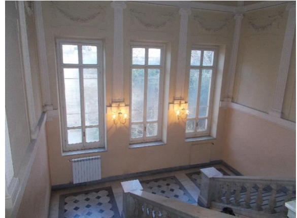
Figura 4.4 - Particolare dei serramenti
